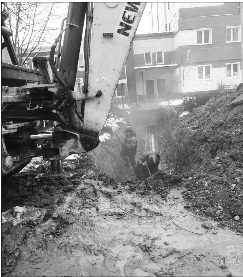
Устранение аварии на теплосетях у городской поликлиники.
