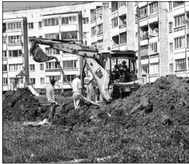
Ремонтные работы на улице Гурьянова
